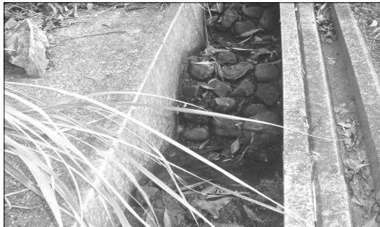
またダム湖面に下る急斜面部である上、水面の変動に対応する必要がある。このため、今回の設計では、切り込みを入れた直徑30cmの塩化ビニル管を階段式に立て込む「塩ビ管立て込み式放流工」を考案して設置した。
