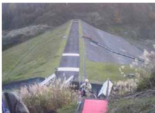
写真-1 川西ダム全景
