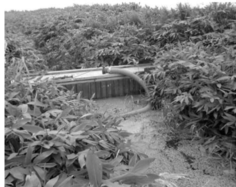
写真-1 堰上げ処理した附帯明渠の状況
