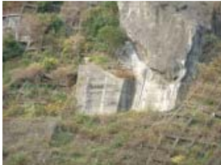
写真-4 全景 A complete view
