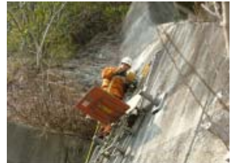
写真-6 作業状況 The work situation
