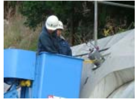
写真-3 試験状況 The test situation
