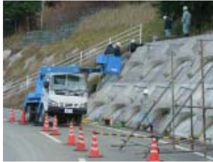
写真-2 設置状況 The jack installed
