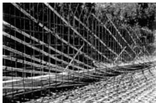
写真 - 1 PC 鋼線配置状況
