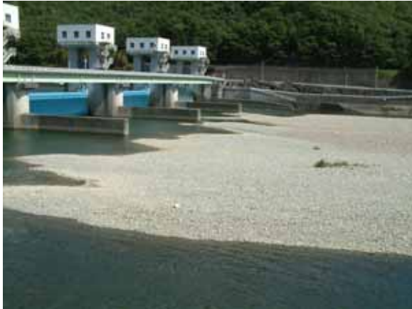
図 3 新田原井堰下流の堆砂(2007.10)
