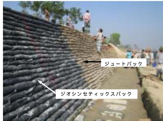
写真-2 ジオシンセティックスパックおよびジュートバックで構築した擁壁斜面
