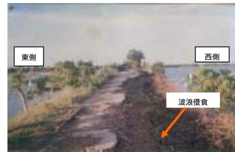
写真-1 毎年の波浪侵食による被害が深刻な道路盛土（パイロット試験工区）
