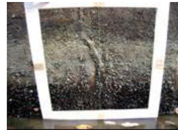
写真 2 側壁に固着するカワヒバリガイ
