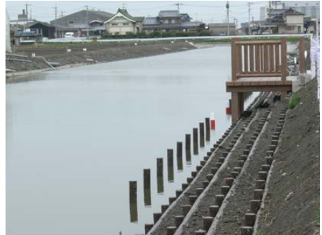
写真－2 「観察型」護岸の親水デッキ
