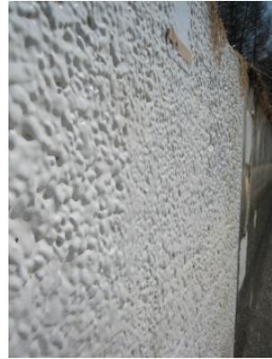
写真-1 断面修復なしにウレタン樹脂を塗布した補修面
