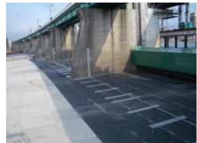
写真-2 犬山頭首工への設置事例
