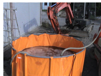
写真 1 組み立て式貯水プールを用いた排水汚泥の貯水試験
