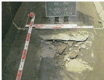
写真-1 既存補修工法のはがれ
