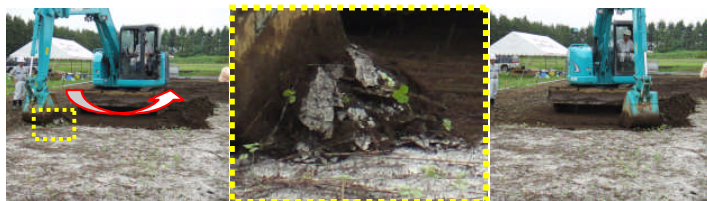
写真2 ワイパー工法による剥ぎ取り状況
