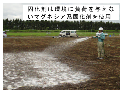
写真1 固化剤の散布
