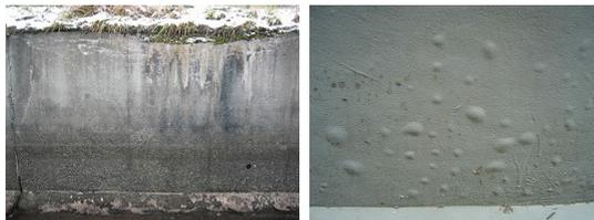
Fig.1 開水路の凍害と表面被覆材の変状
