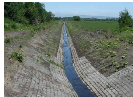
写真-1 連節ブロック型排水路 Connected block type drainage canal
