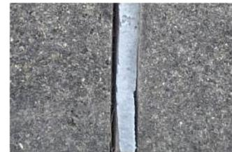
写真1 目地材の界面剥離
