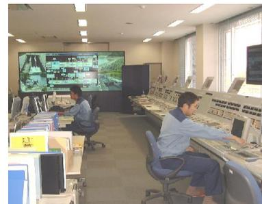
(3) **バックアップシステム** 中央操作室では監視データが正常値の範囲内であることを常時監視しているが、範囲を逸脱する異常時には警報（ブザー）を吹鳴させることとしている。中央操作室のシステムにトラブルが発生した場合においても、出先管理所に配備したシステムで監視・操作ができるようにしている。
