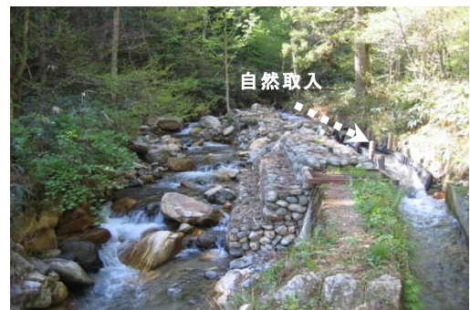
写真-2 栗尾沢堰 着工前 Kuriosawaseki before
