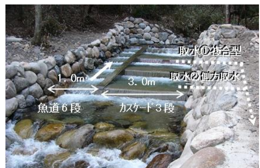
写真-3 栗尾沢堰 竣工 Kuriosawaseki after
