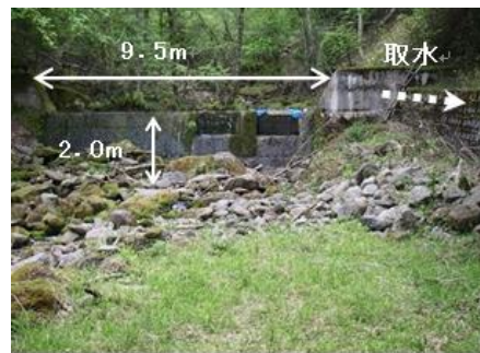
写真-4 上人沢取水工 着工前 Shounizawa before
