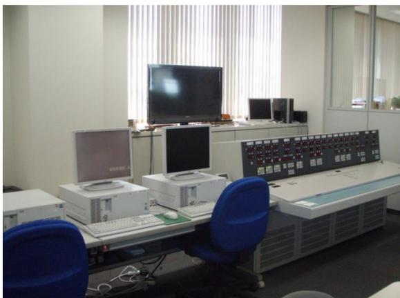
図1 遠方操作・監視装置
