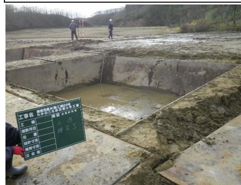
写真2 攪拌ヤード完成 Photo2 agitation yard completion
