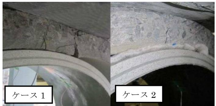
Fig. 5 老朽管と更生管の接触状況
