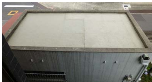
写真2 被覆後の屋上の状況
