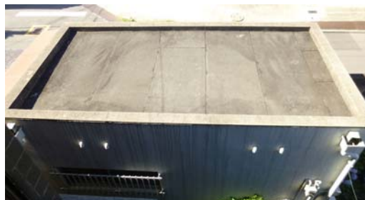
写真1 被覆前の屋上の状況
