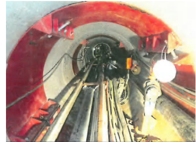
写真-5 仮設鋼製バンド取付後
