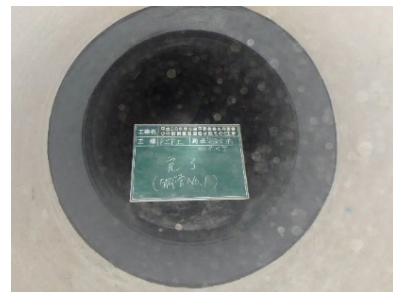
写真-6 パイプインパイプ施工後
