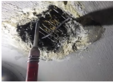
写真-3 玉石調査状況
