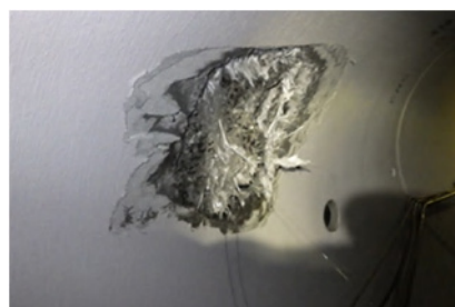
写真-2 9本目 破損状況
