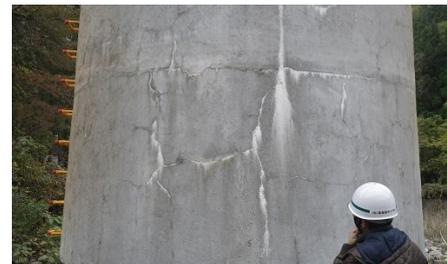
図1 吹付施工後の橋脚表面の亀裂
