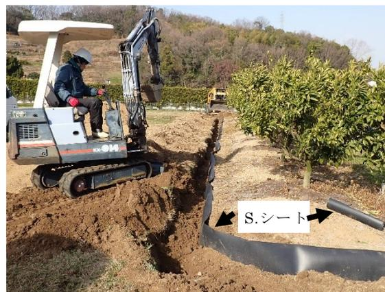
図2 S.シートの埋設工事
