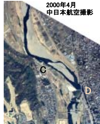
図-3 羽村堰の現況
