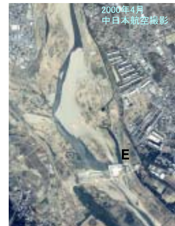
図-4 昭和堰の現況
