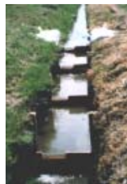
堰き上げ状況
