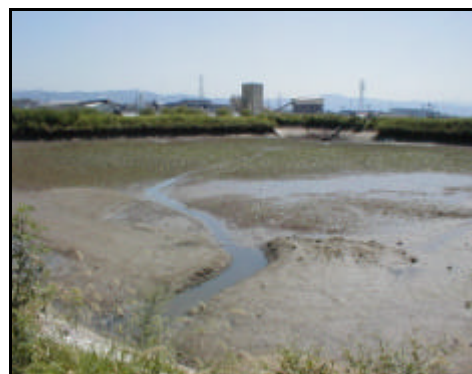
写真1 ため池状況（落水後、施工前） / State of Reservoir (Before Construction)
