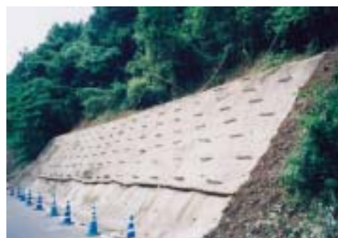
写真 3 ミラクルボードの設置状況
