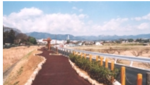
写真2 アスウッド舗装 / Aswood pavement
