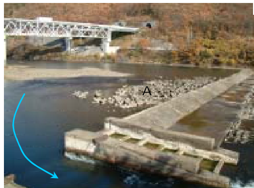
図-2 旭川合同用水堰(岡山県)上流のミオ筋
