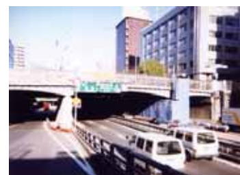
写真-2 補強完成
