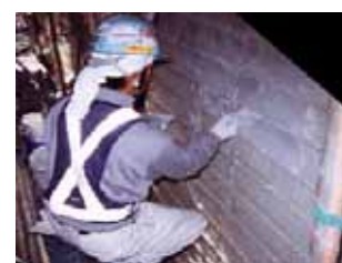
写真-3 増厚状況
