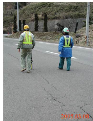
写真-1 ひび割れ長さ測定状況
