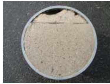
エアモルタル
