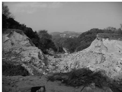
写真4 ため池の決壊 Irrigation pond break
