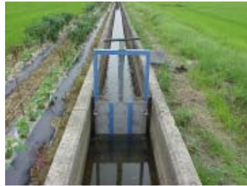
図2．改良分水ゲート Improved diversion gate
