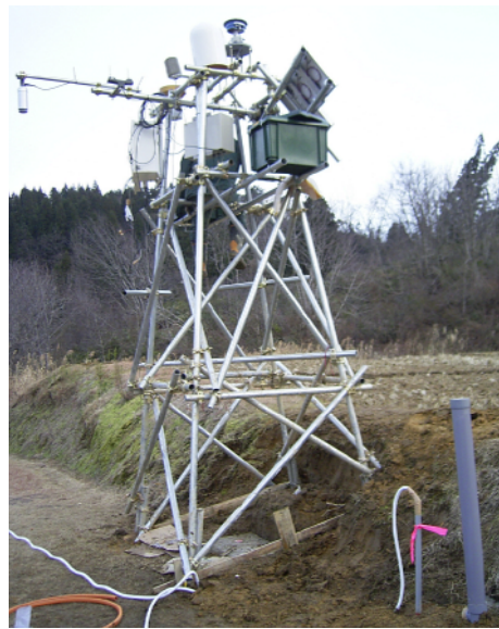
Fig.2 地すべり地土塊移動量および間隙水圧の連続観測システム
