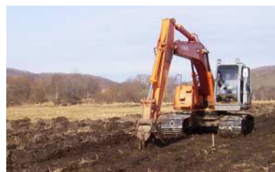
写真1 埋木処理の施工
