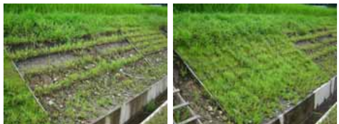
3 切土施工 (すじ)
