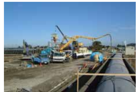
写真 - 2 打設状況
