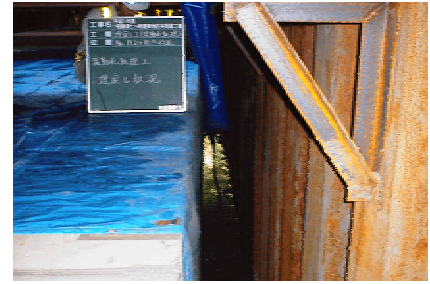
写真 - 1 埋戻し状況
