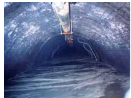
写真 - 3 充填状況
