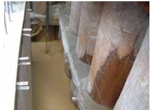
写真 1 LSS 打設状況
