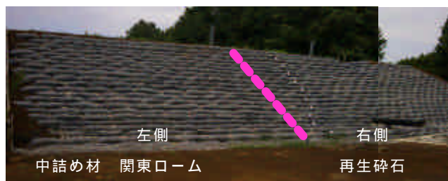
写真-1 完成後の様子 The small earth dam after construction
