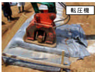
写真-3 転圧の様子 Compaction of soil bag
