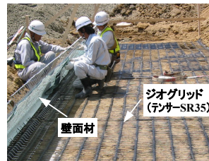
図-4 壁面・ジオグリッドの設置
