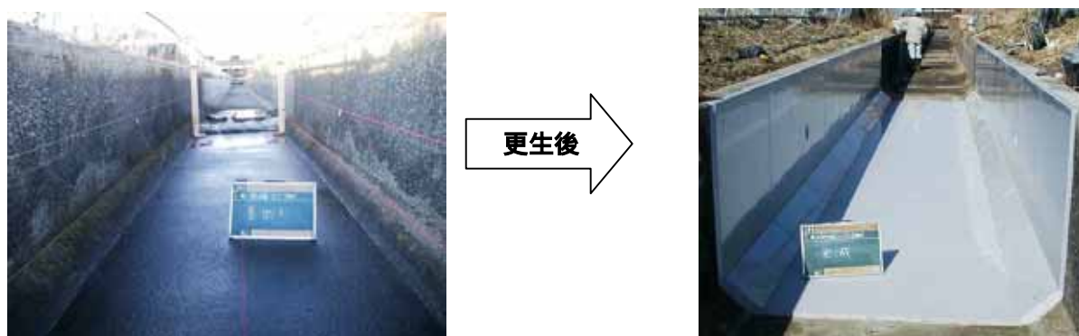
(2) 直貼工法(三面開水路:群馬県内)
