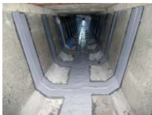
Pic.2 目地補修
