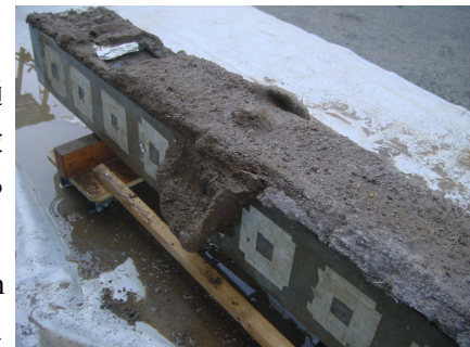
Photo1 注入後の状況
