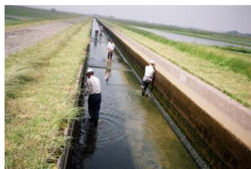
写真 1 人力による藻刈り状況 Photo1 Cutting Down of Algae by Human Power(写真提供:改良区)
