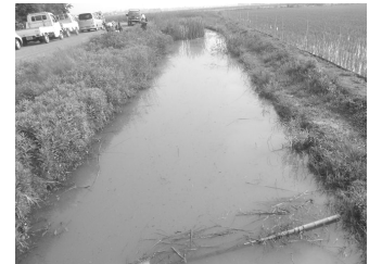
写真-1 土水路 Pic-1 Unlined canal
