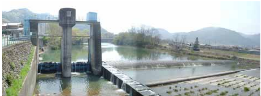
（写真 - 1）改修前の頭首工と魚道
