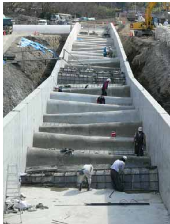
(図-1)ハーフコーン型魚道の構造
