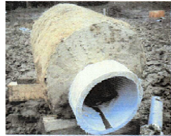
Pic.1 固化材支承された更新管
